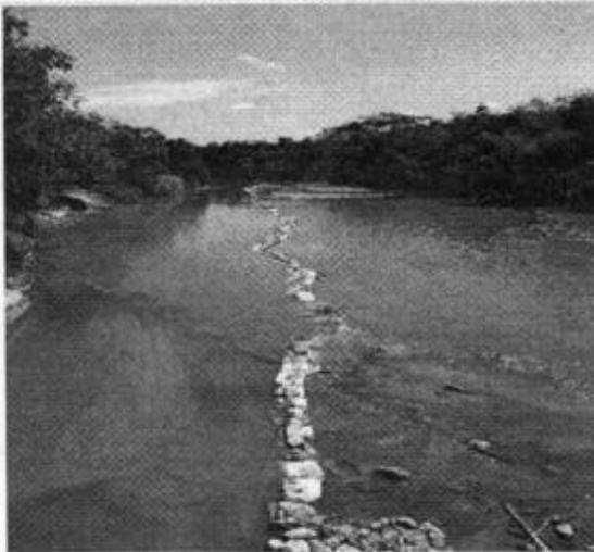
**Foto 9.** Sector Suramerica, Trincheras que cruza el rio Aracataca con el fin de desviar una gran porcion de agua del del rio hacia el canal identificado anteriormente.
