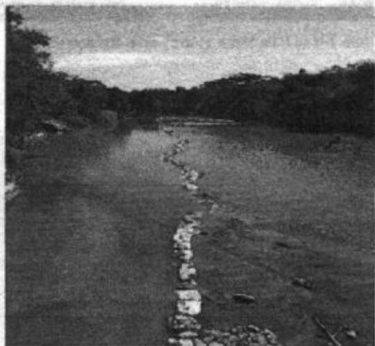
Foto 9. Sector Suramerica, Trincheras que cruza el rio Aracataca con el fin de desviar una gran porcion de agua del del rio hacia el canal identificado anteriormente.
