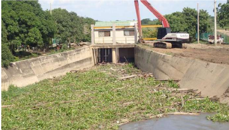
Figura 4-25. Detalle de restos vegetales, residuos sólidos en la zona de compuertas de la estación Renegado.
