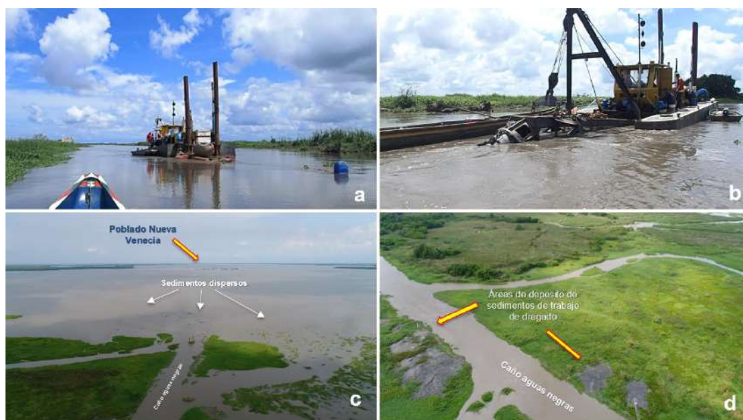
Figura 4-21. Imágenes de la máquinas y zona donde se estuvo realizando el dragado en el Caño Aguas Negras, en el Sector de Pajarales – Nueva Venecia (a, b y c), la imagen (d) detalla los lugares donde se ubicaron sedimentos del dragado y que podrán reincorporarse si ocurre crecientes súbitas en Caño Aguas Negras.
