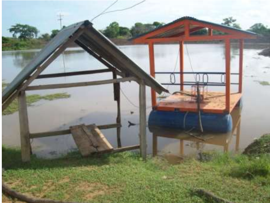
Figura 66. Bocatoma Dársena Caño de Agua
