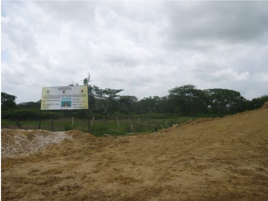
Figura 73. Vía que comunica al municipio de Pivijay con el municipio de Salamina. Fuente: TOMADA DE VISITAS DE VERIFICACIÓN UNIVERSIDAD DE CARTAGENA.
