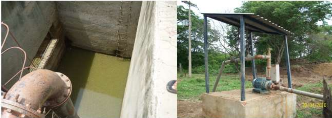
Tanque de Captación de Agua – Acueducto (Chibolo) Estación de Bombeo Las Canoas (Pivijay)
