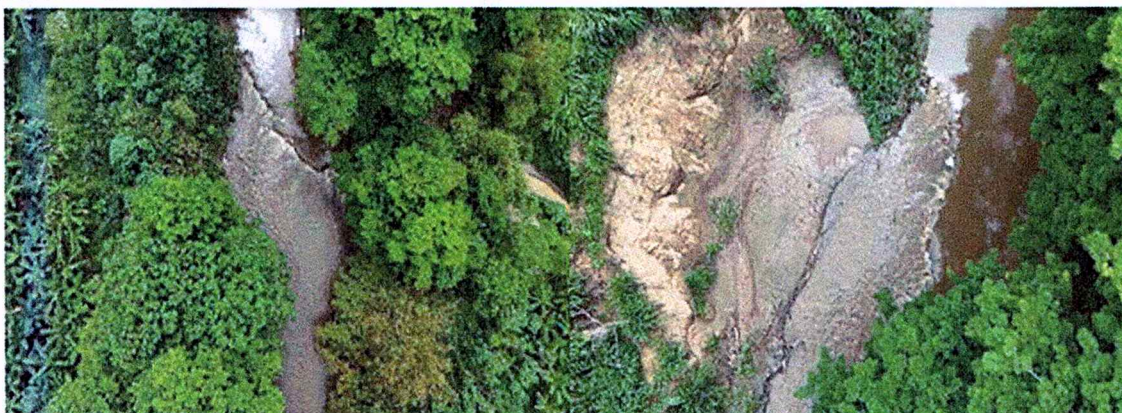
Trincho Predio Don Fuad 1
