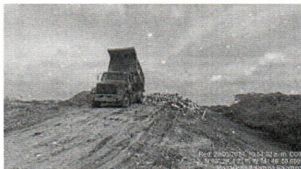
Fotografía No. 1. Disposición de residuos sólidos en la celda No. 5.
