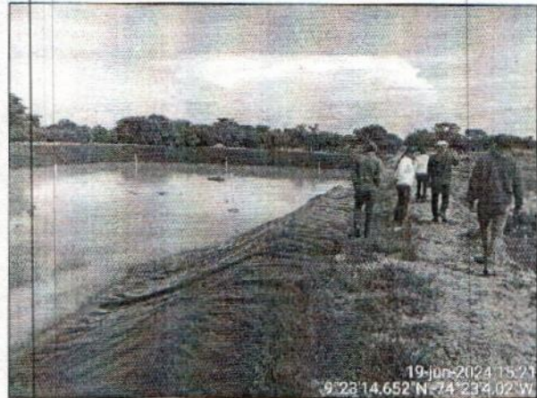
Fotografía No. 4. Celda de disposición final con agua empozada.
