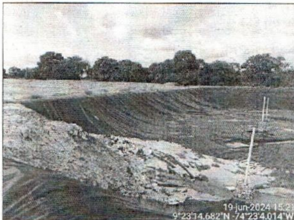
Fotografía No. 5. Residuos dispuestos en la celda operativa.
