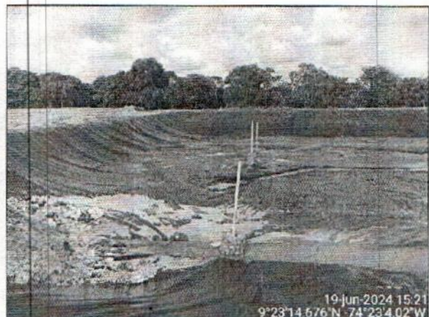
Fotografía No. 6. Residuos dispuestos en la celda operativa.
