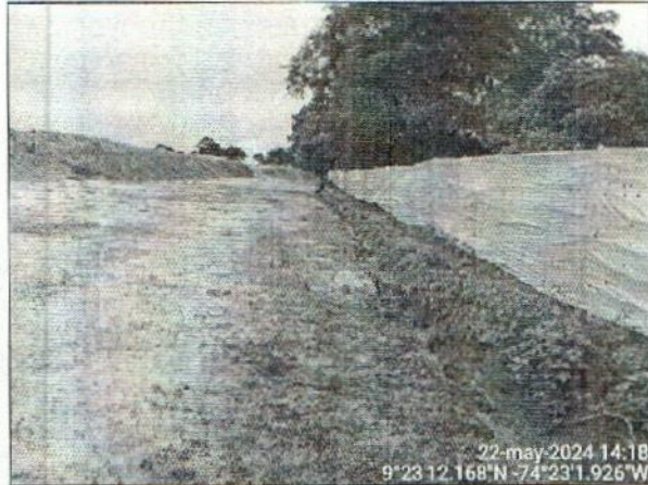
Fotografía No. 16. Canal de drenaje de agua lluvia construido en terreno natural.
