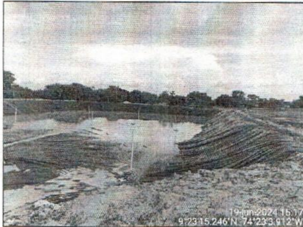
Fotografía No. 3. Celda de disposición final con agua empozada.
