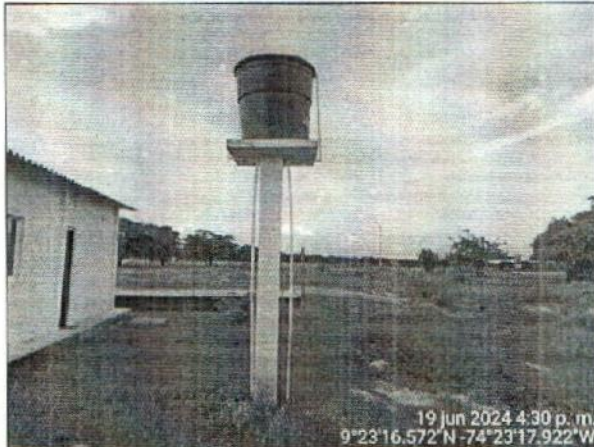
Fotografía No. 15. Tanque elevado de almacenamiento de agua.
