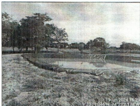
Fotografía No. 7. Piscina de lixiviados.
