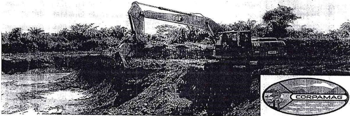
Retroexcavadora hidráulica sobre orugas, marca Caterpillar, modelo 320 GC, observada en operación durante la diligencia de verificación. La máquina, de gran tamaño y color amarillo característico, está equipada con brazo articulado y cuchara metálica para labores de remoción de material en proyectos de excavación a cielo abierto. En el costado se identifica el proveedor GECOLSA. Su uso se asocia comúnmente a actividades extractivas de gran escala.
