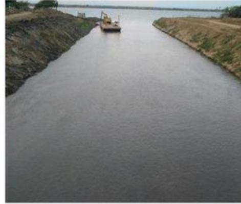
COMENTARIOS: Vista del canal de entrada del caño renegado con la sección hidráulica totalmente recuperada y habilitada para la entrada de flujo en niveles bajo que pueda tener el río Magdalena.
