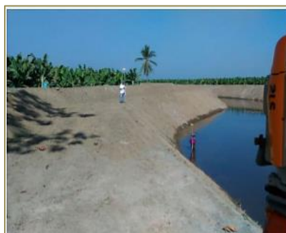
Comentario: Río Frío labores de dragado mecánico
