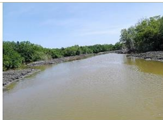
Dragado mecánico Caño Ahuyama
