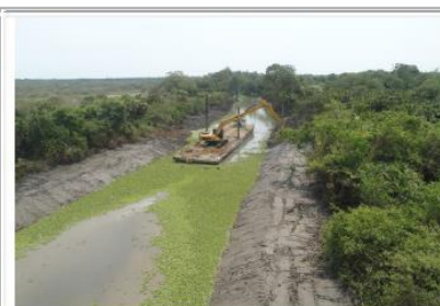
COMENTARIOS: Trabajos sobre el caño El Burro – Marzo de 2018
