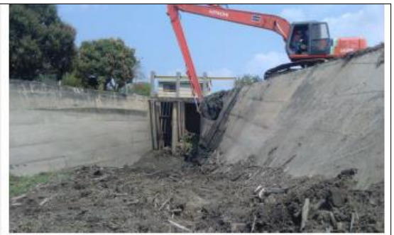
COMENTARIOS: Dragado en las compuertas del caño Renegado – 14/03/2018
