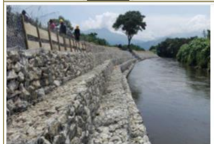
Comentario: Construcción de gaviones río Frío.
