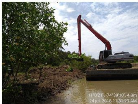
Retiro de terraplenes en el Caño Clarín Nuevo – Visita del 24/07/2018
