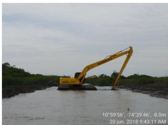
Retiro de sedimentos en el Caño Márquez – Visita del 20/06/2018
