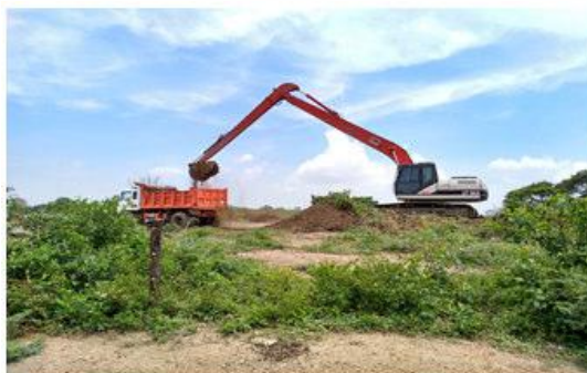
Retiro en volqueta de los sedimentos dragados y dispuesto a la altura del K1+100 – Visita del 21/08/2018
