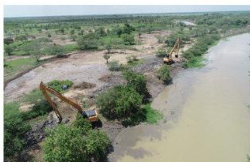
Dragado del caño Renegado entre las abscisas K8+000 y K8+620
