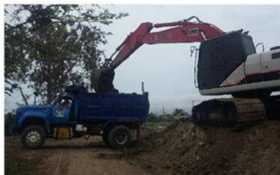
Repaleo de material para disposición final
