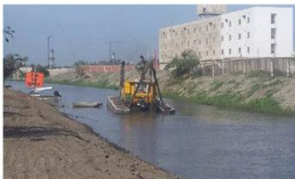
Dragado Hidráulico Abscisa K1+420.
