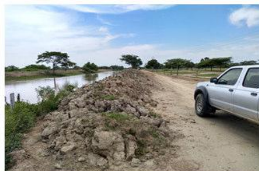
Panorámica del dragado realizado en el K6+000 del caño Renegado – Visita del 18/08/2018
