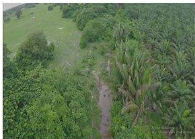
Estado del drenaje “El Mudo” antes de la intervención k1+750
