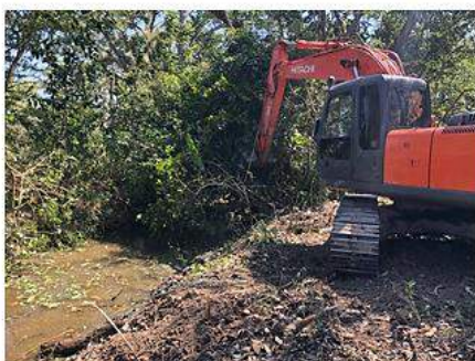
Estado drenaje “El aji”, antes de la intervención K19+750
