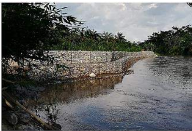
Panorámica de las obras - Vista aguas arriba
