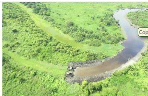
COMENTARIOS: Río Frio – Sevilla, después durante la intervención. Retiro de sedimentos y material vegetal.
