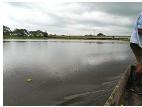
Después de actividades Caño Schiller PR0+350: puente concreto – finca el Oriente
