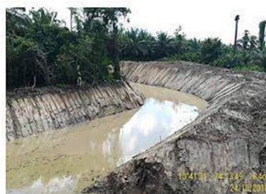
Estado tramo K3+600 al K4+800 posterior a intervención
