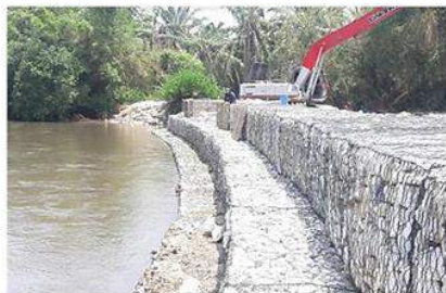
Construcción cuarto nivel de gaviones
