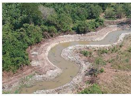
Estado drenaje “El aji”, después de la intervención K19+750
