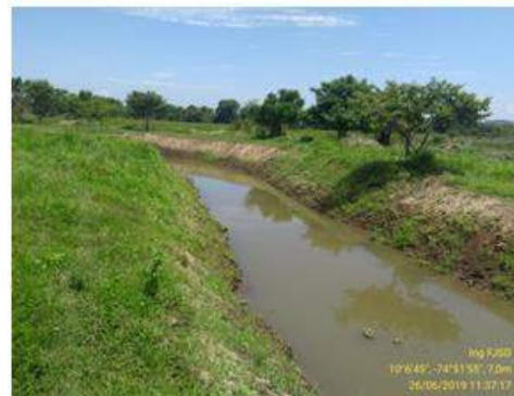
Vista después de la intervención
