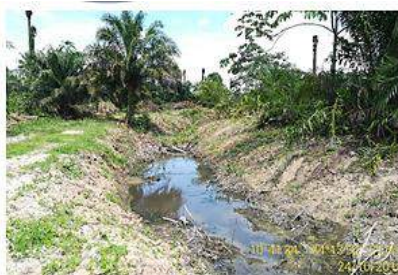
Estado inicial tramo K3+600 al K4+800
