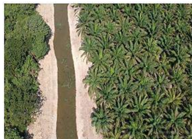
Estado del drenaje “El Mudo” después de la intervención - k1+750
