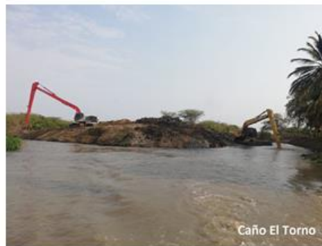
Retiro de material en Caño El Torno
