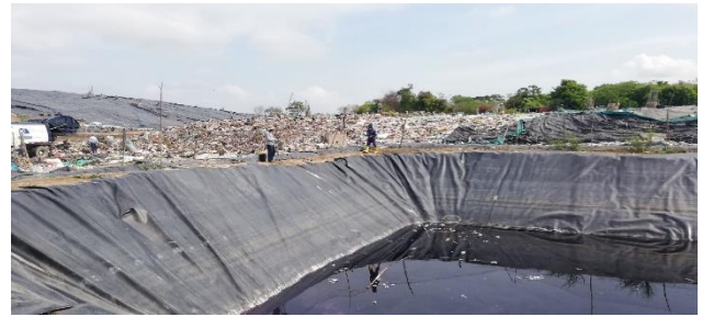
Control y Seguimiento Laguna de Oxidación, Municipio de Ciénaga
