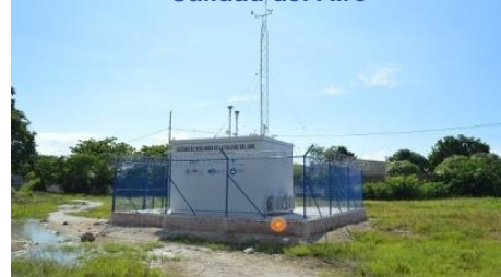
Figura 28 Estación de monitoreo de la Calidad del Aire
