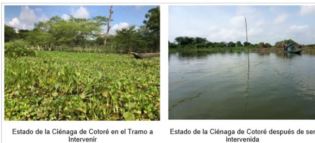
Figura 76 Avance de Obra Convenio N° 483 de 2021
