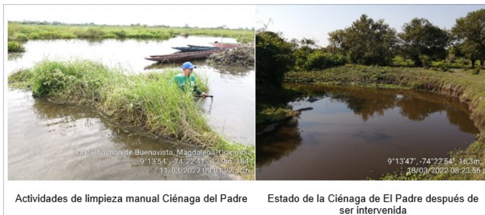
Figura 77 Avance de Obra Convenio N° 484 de 2021
