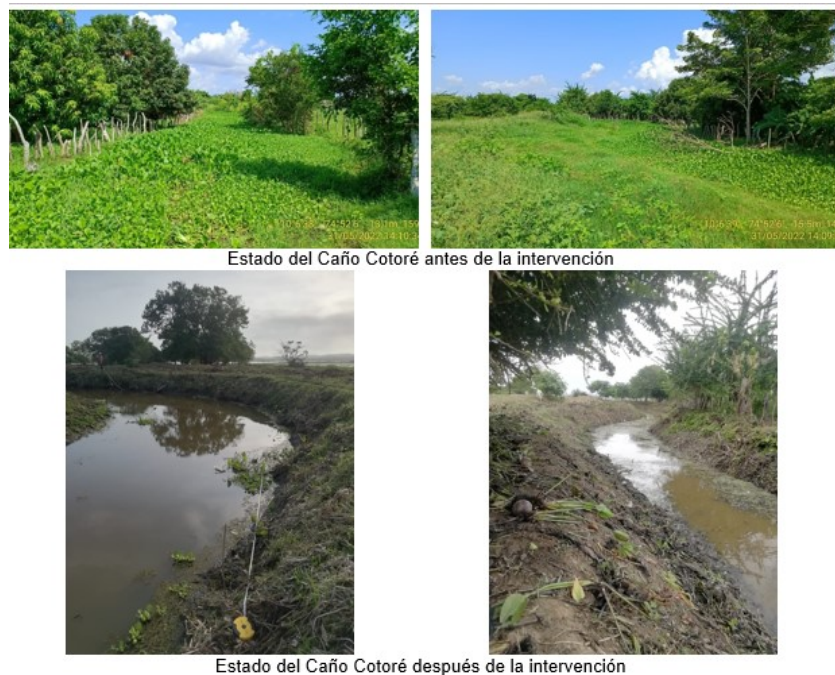
Figura 67 Avance de Obra Convenio N° 217 de 2021
