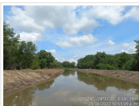
Caño El Burro - Dragado Mecánico del K12+000 al K10+400.
