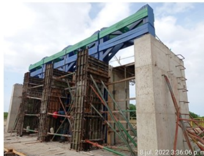
Actividades de instalación compuertas - Caño el burro.
