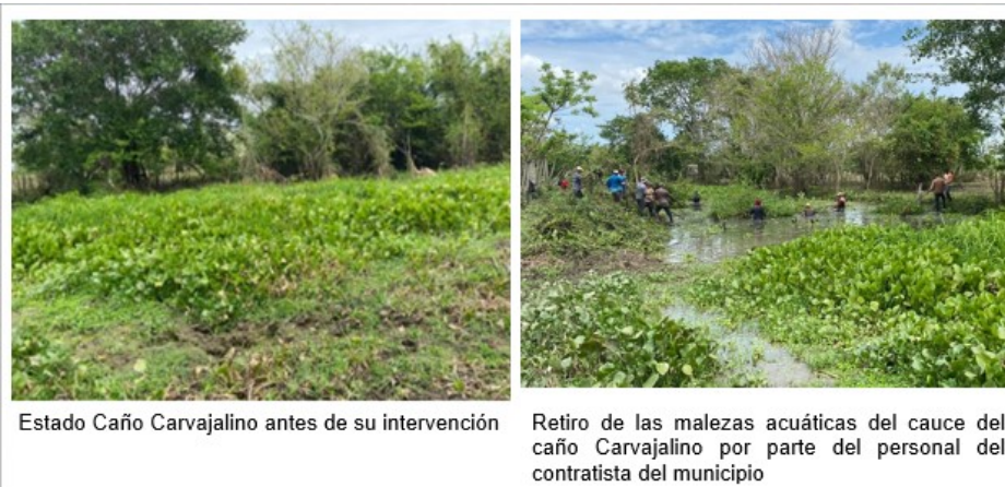
Figura 75 Avance de Obra Convenio N° 482 de 2021
