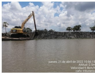
Actividades de perfilado talud caño Renegado
