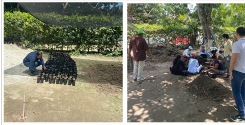
Figura 80 Instalación de un vivero transitorio
