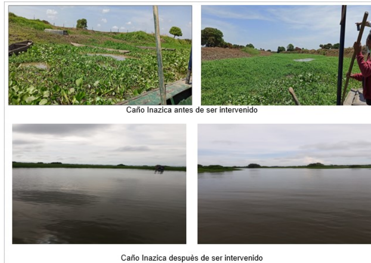
Figura 71 Avance de Obra Convenio N° 477 de 2021
