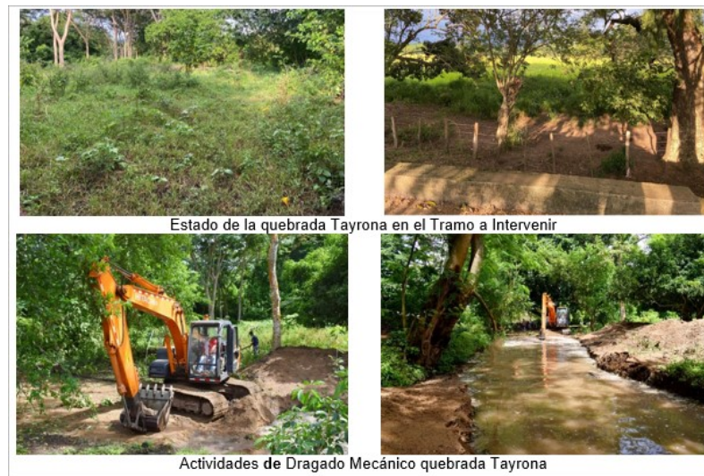
Figura 68 Avance de Obra Convenio N° 472 de 2021
