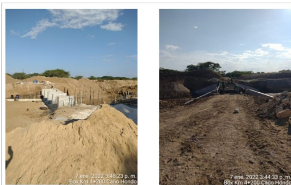
Figura 51 Actividades de Construcción de Box Culvert en Concreto Reforzado
