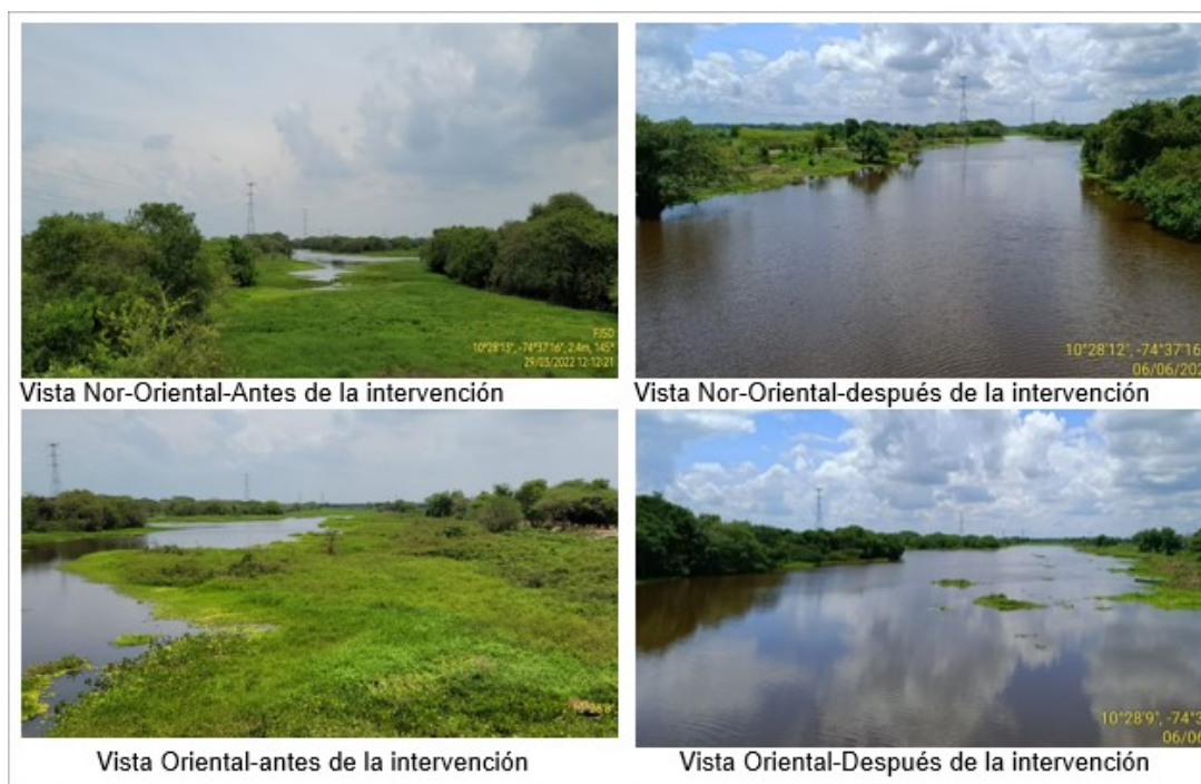
Figura 69 Avance de Obra Convenio N° 474 de 2021
