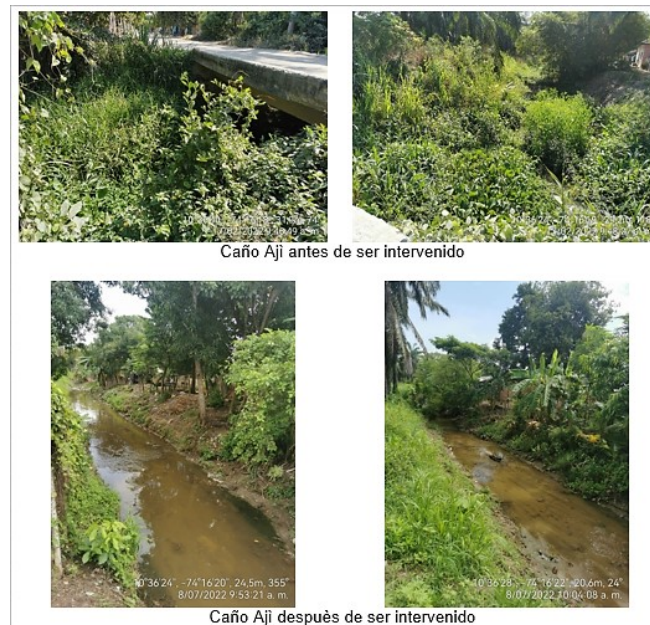
Figura 72 Avance de Obra Convenio N° 478 de 2021
