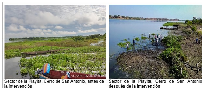
Figura 73 Avance de Obra Convenio N° 479 de 2021
