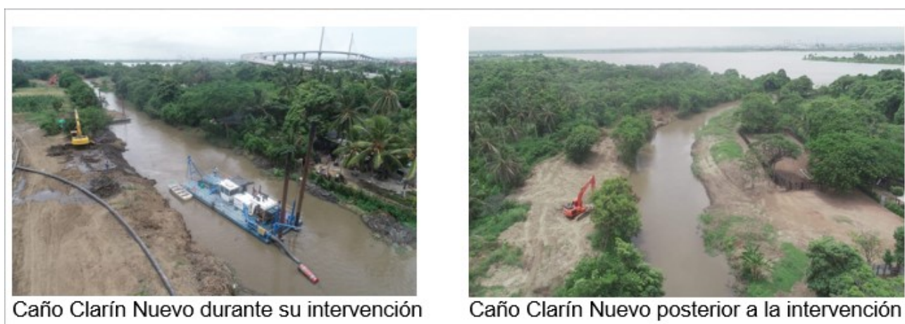
Figura 53 Avance de Obra LP 002 DE 2021
