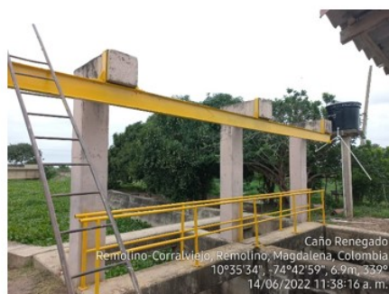
Adecuaciones en Compuerta Caño Renegado – Pintura de exteriores
