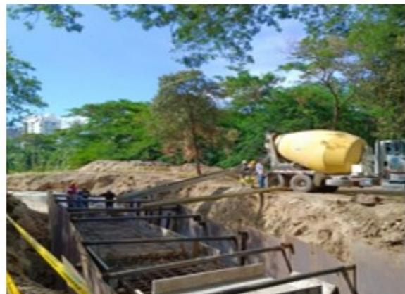
Concreto para losa de superior de canal de conducción a cámara de caída en la desembocadura
