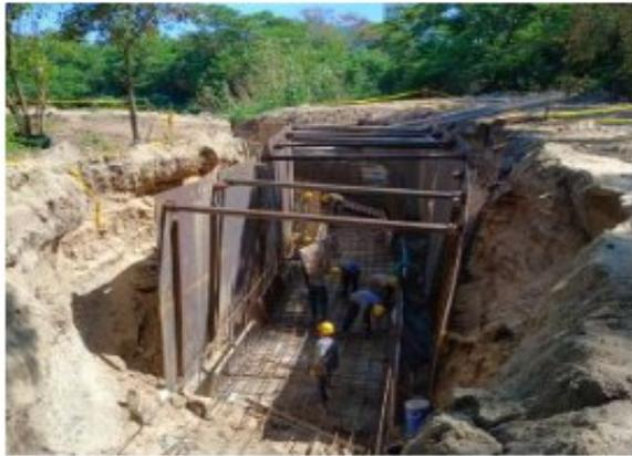
Instalación de entibado metálico para construcción de canal cerrado, sector desembocadura
