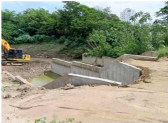
Relleno con material seleccionado, cámara de caída en la desembocadura
