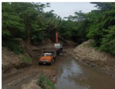
Retiro de escombros y sedimentos mediante cargue mecánico con excavadora sobre orugas.
