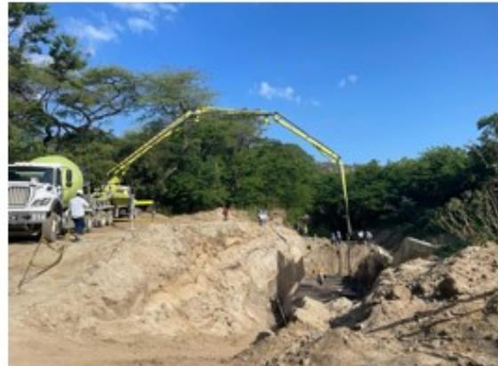
Bombeo de concreto para fundida de losa de fondo de cámara de caída en la desembocadura
