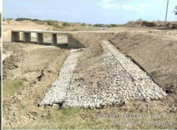
Conformación de Colchogavión talud derecho aguas arriba del Box Culvert del K170
