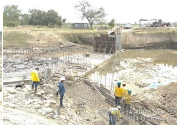
Construcción de Box Culvert #5, ubicado en la abscisa K15+375
