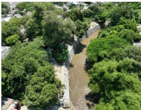
Obras de protección de Taludes para controlar procesos erosivos – Sector Minuto de Dios
