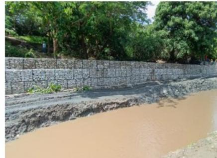
Obras de protección de Taludes para controlar procesos erosivos – Sector Nuevo Milenio
