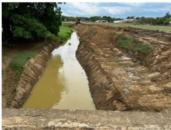
Limpeza Mecánica de vegetación. Incluye disposición de materiales removidos sobre las márgenes adyacentes al cuerpo de agua.
