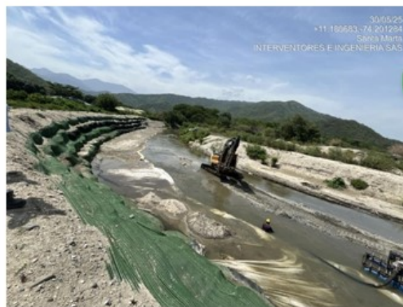
Protección de Márgenes con muro en Geocontenedores sobre le río Gaira en desembocadura de quebrada Bureche
