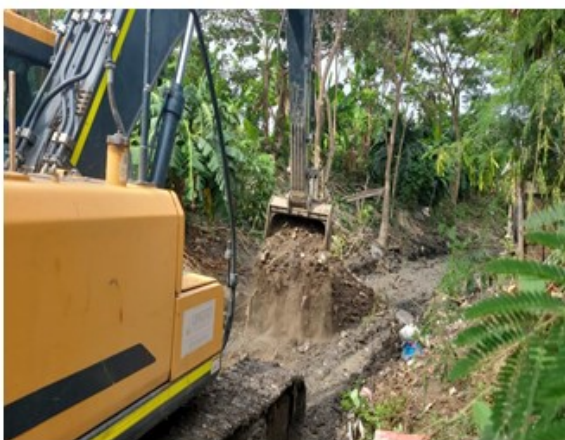
Remoción de sedimentos para la preservación de la sección hidráulica de la Quebrada Bureche
