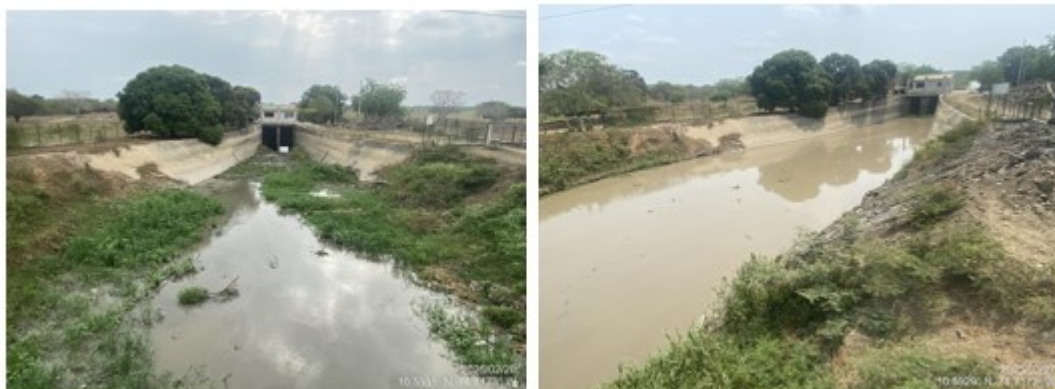
Figura 68 Ejecución Dragado Mecánico Caño Renegado - Antes y Después
