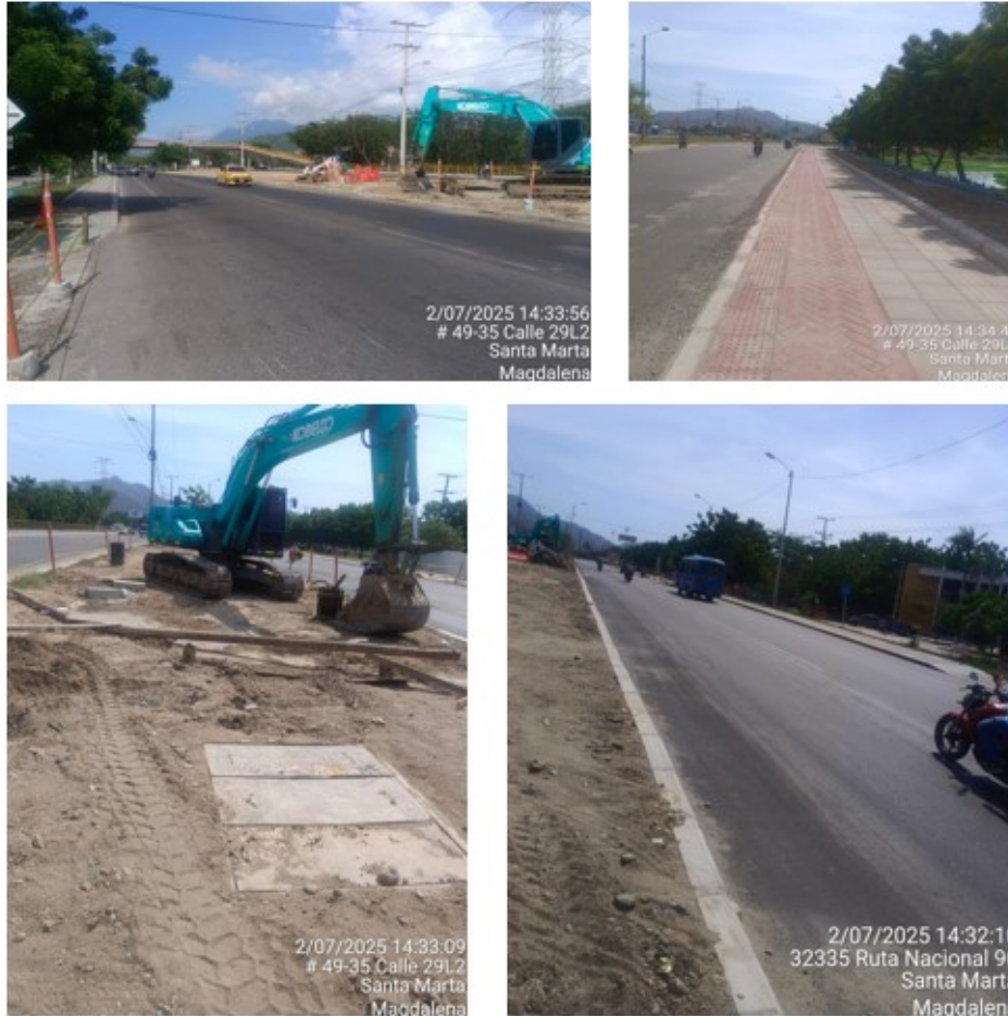
Figura 78 Obras Quebrada Japón, Distrito de Santa Marta
