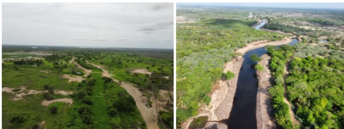
Figura 67 Ejecución Dragado Mecánico Caño Salado - Antes y Después
