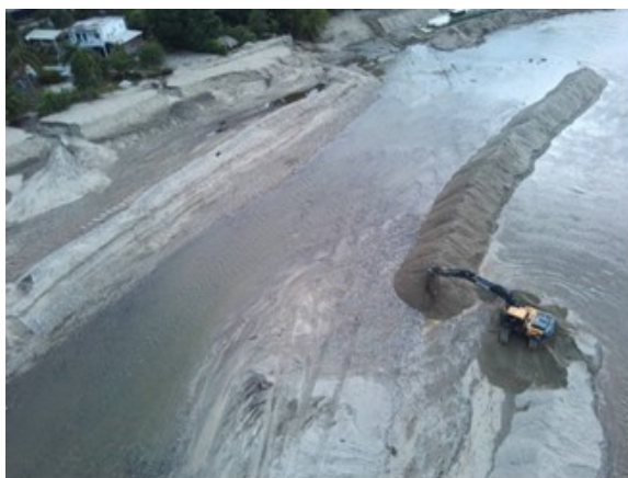
Remoción de sedimentos para la preservación de la sección hidráulica del río Piedras
