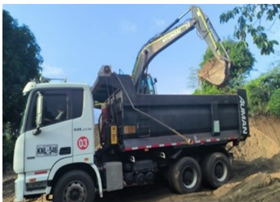
Cargue y retiro de sedimentos para mejoramiento y preservación de la sección hidráulica del río Piedras
