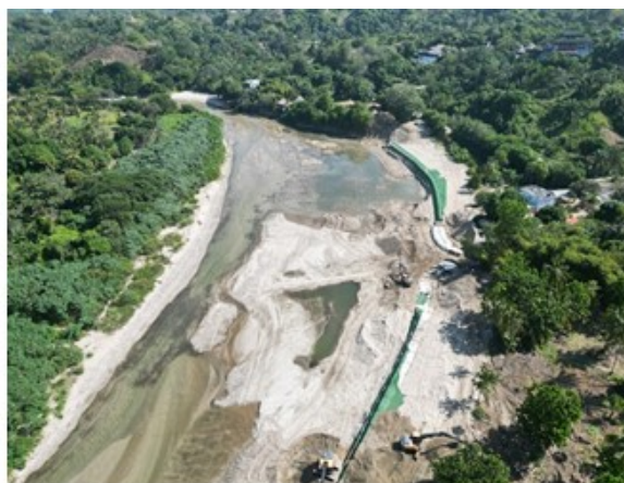
Protección de Márgenes con muro en Geocontenedores sobre le río Piedras
