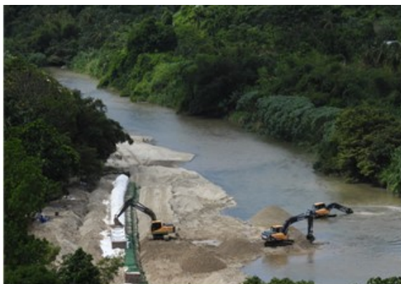
Construcción de muro en Geocontenedores para mejoramiento y preservación de la sección hidráulica del río Piedras
