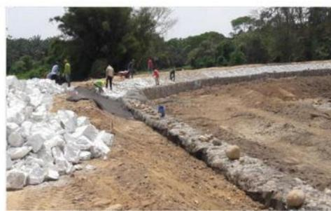
Sector Garrapata 1 Avances en la construcción de los gaviones y Colcho gaviones-d.
