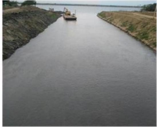
COMENTARIOS: Vista del canal de entrada del caño renegado con la sección hidráulica totalmente recuperada y habilitada para la entrada de flujo en niveles bajo que pueda tener el río Magdalena.
