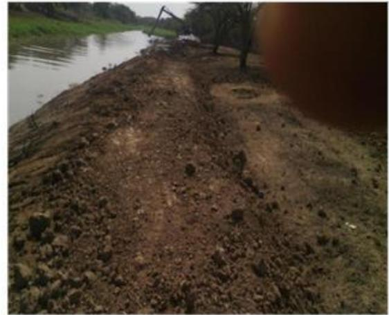
COMENTARIOS: Retroexcavadora CAT 324 de brazo largo realizando la labor de dragado mecánico y recuperación de la sección hidráulica del caño Renegado en la abscisa K7+500
