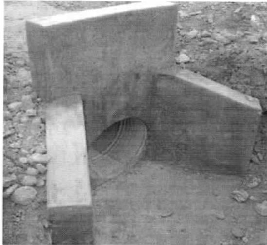
El instalador de las alcantarillas deberá garantizar una pendiente hacia el complejo cenagoso de 1.3%, correspondiente a un desnivel de 0.2 m.
