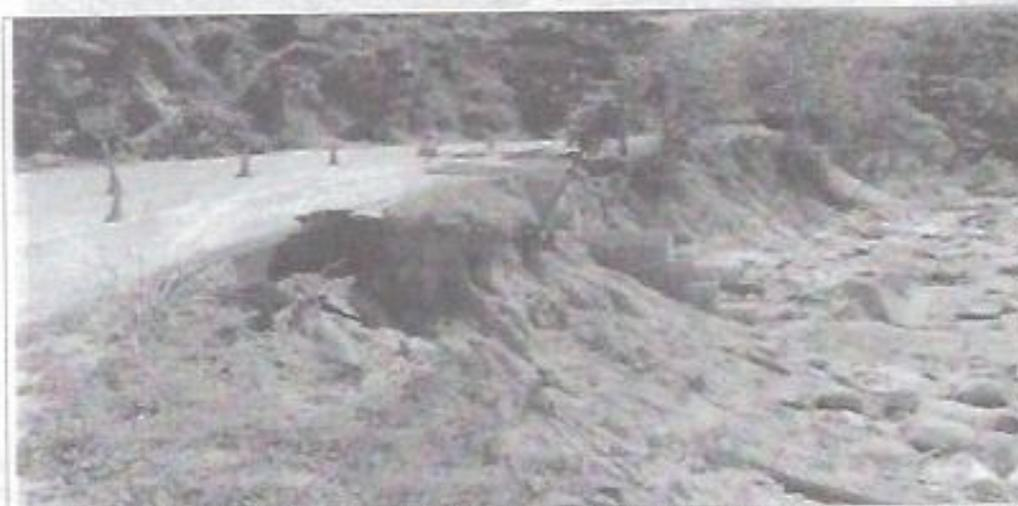
En la fotografía siguiente, se aprecia el nuevo bordillo construido bajo emergencia, como una medida de restablecer de manera temporal el control de la escorrentía de la vía, y los conos de señalización de la restricción vehicular impuesta en el sector.
