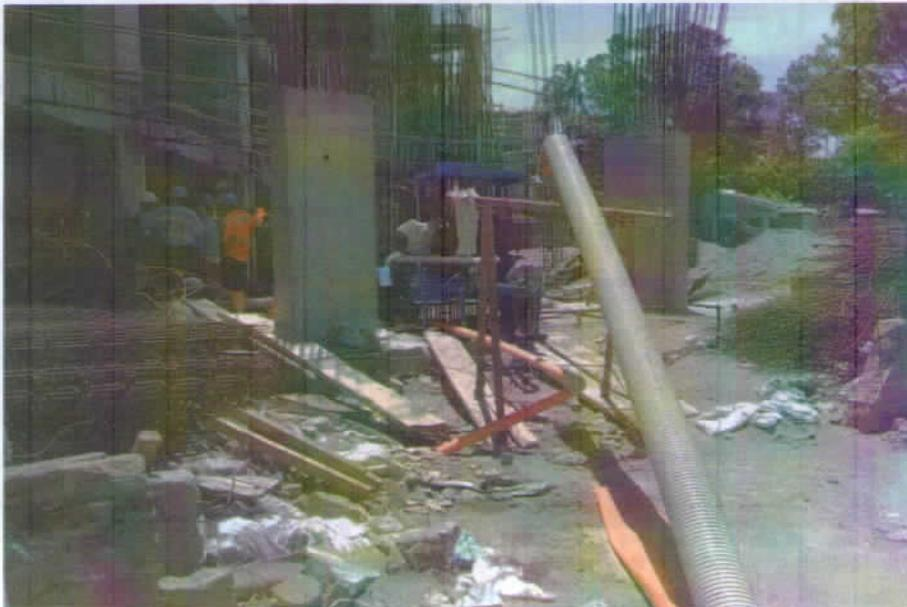
FOTO 3. Zona de bombeo de las aguas de nivel freático donde se muestra la suspensión del vertimiento.
