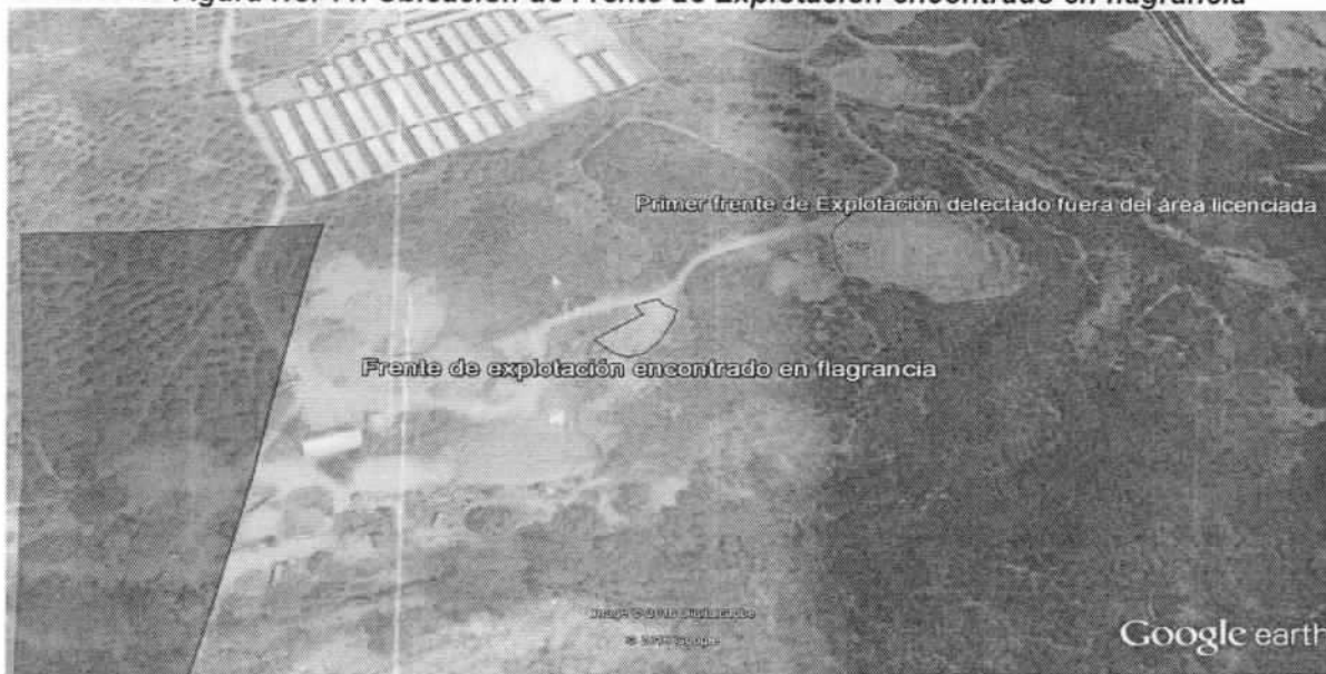
Figura No. 11. Ubicación de Frente de Explotación encontrado en flagrancia
