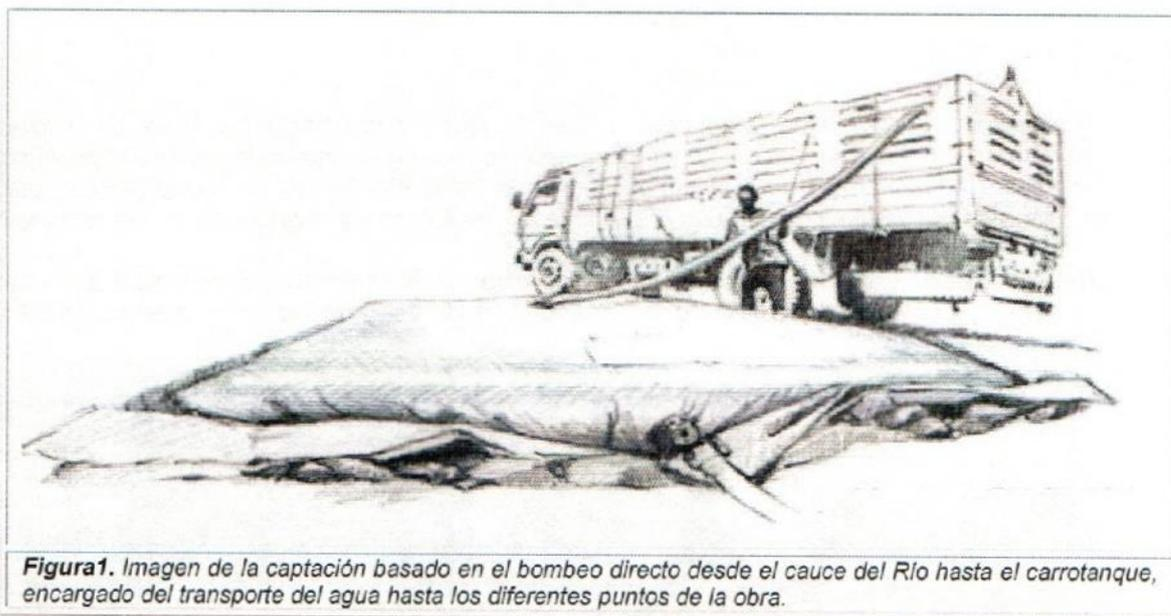
**Distribución:** El sistema de captación a implementar, está basado en el bombeo directo desde el cauce del río hasta el carrotanque, encargado del transporte del agua hasta los diferentes puntos de la obra.
