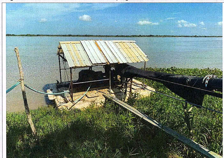
Foto 1. Barcaza flotante en la captación de aguas superficiales del predio La Bonga
