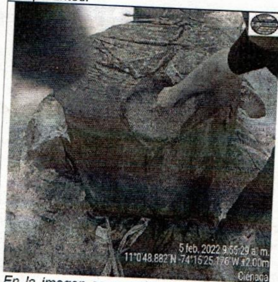
En la imagen se muestra el relleno de cantera con material de granulometría muy distinta al de la playa
