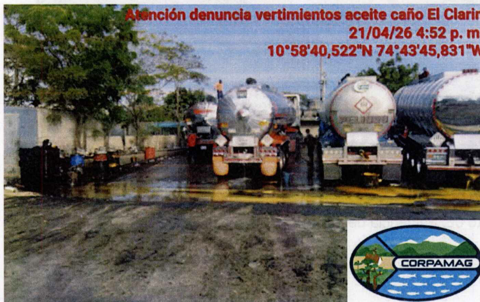
Foto 04. Evidencia de lavado de tractomulas en el lavadero que contienen aceites e hidrocarburos
