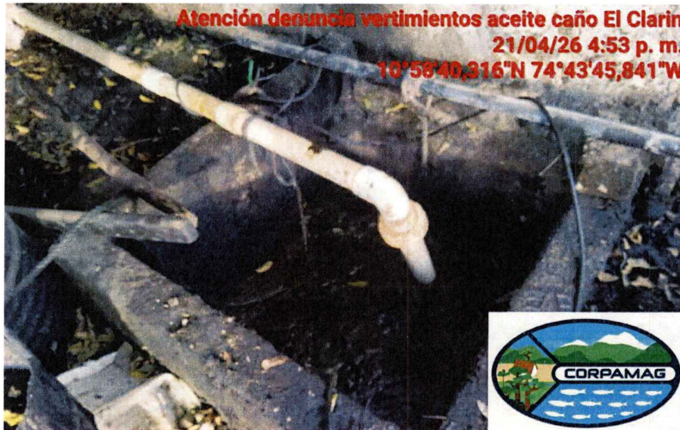
Foto 09. Evidencia de presunta captación de agua mezclada con residuos de hidrocarburos
