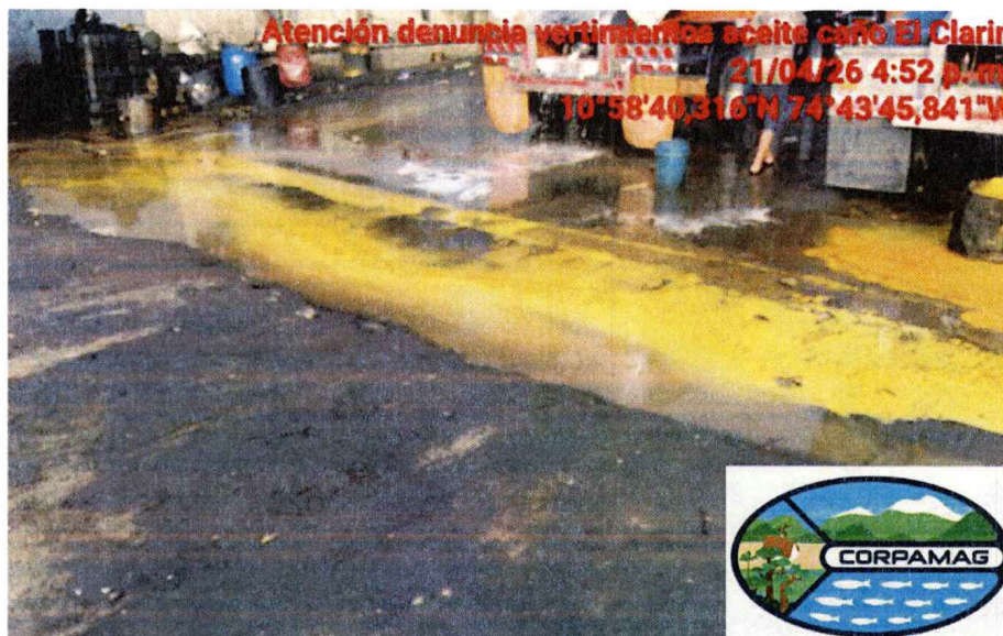
Foto 06. Evidencia de colmatación y rebose del sistema de drenaje
