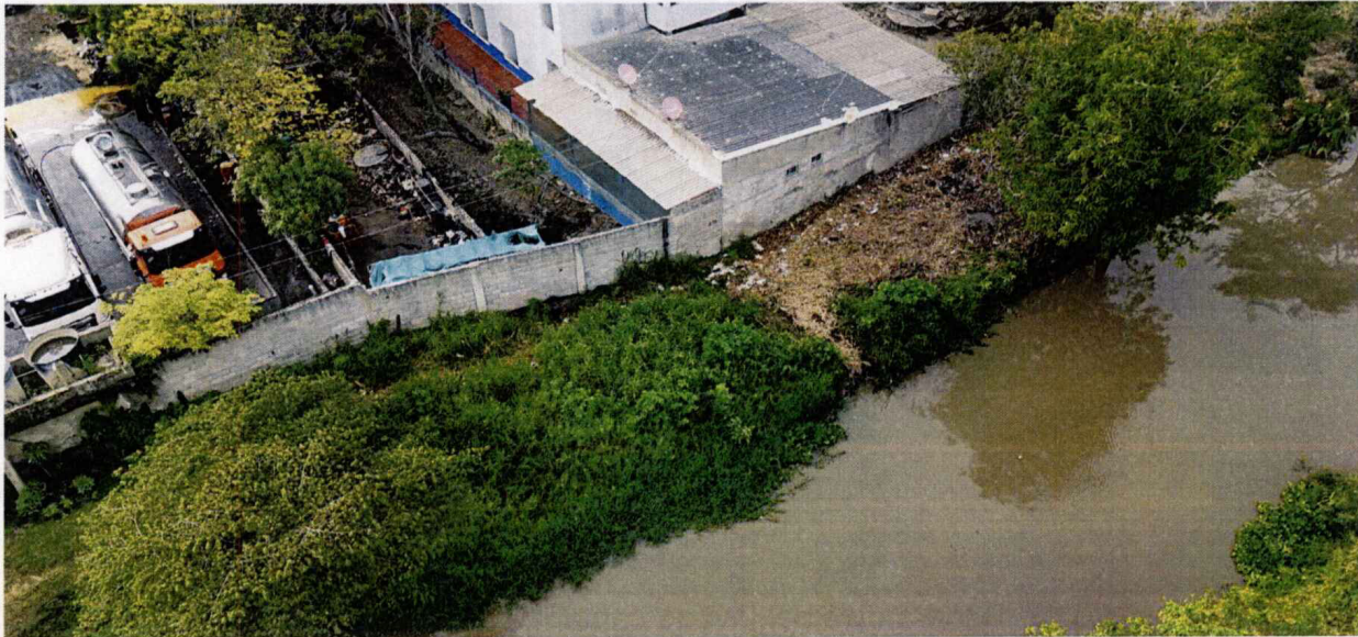
Foto 15. Foto captada por el DRON que muestra la zona donde se realiza la descarga
