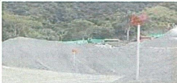
Figura 2. Identificación áreas de almacenamiento de materiales
