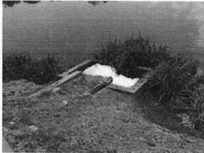
**Figura 12** Estructura de entrega de aguas residuales a laguna de maduración.
