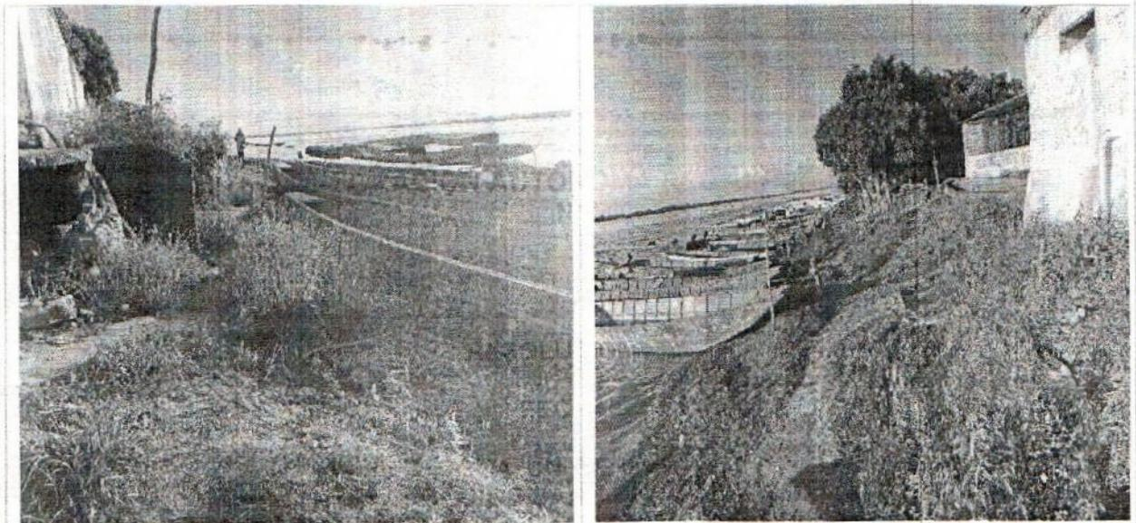
Foto1 y 2. La margen derecha donde se realizara la intervención, está conformada por depósitos aluviales constituidos principalmente por arcillas de baja plasticidad formando taludes con tendencia a la inestabilidad. La cobertura vegetal integrada por arboles aislados y pastos limpios, es de escaso interés ambiental pero fundamental en la estabilización de las masas de suelo.
