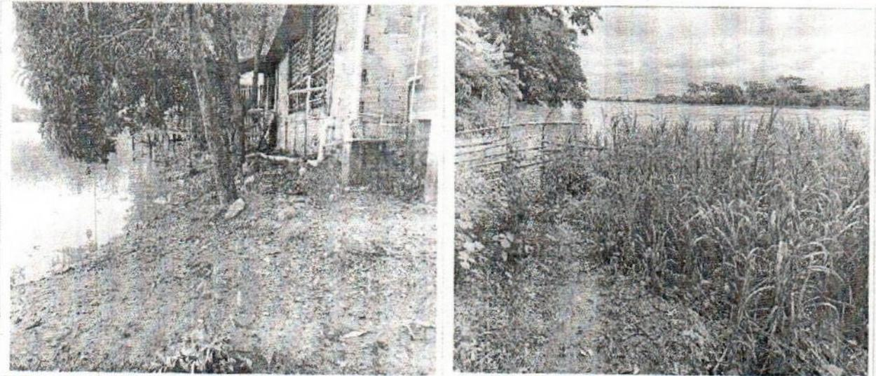
Foto1 y 2. La margen derecha donde se realizará la intervención, está conformada por depósitos aluviales constituidos principalmente por arcillas de baja plasticidad formando taludes estables. La cobertura vegetal integrada por arboles aislados y pastos limpios, es de escaso interés ambiental pero fundamental en la estabilización de las masas de suelo.
