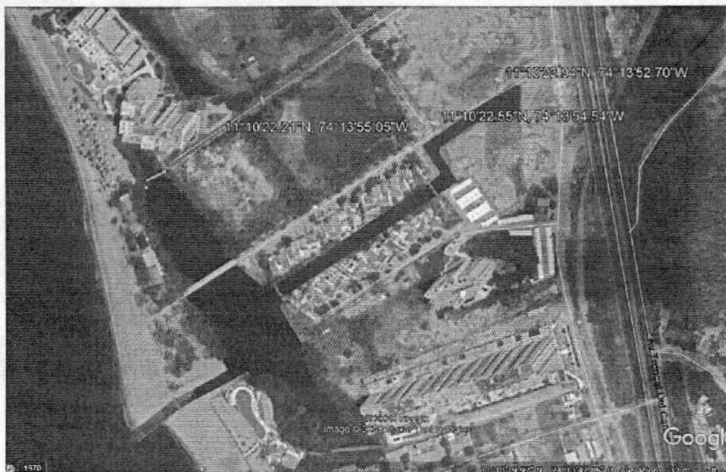
Imagen 3. Ubicación de los pozos de inspección en el sector objeto de la denuncia y un punto de comunicación del Humedal Costero con el Mar Caribe.
