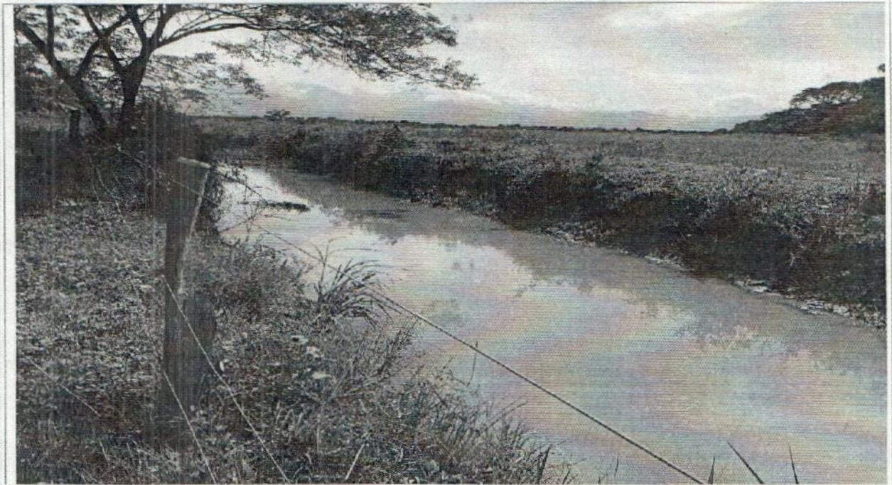
Foto2. Canal no revestido usado como estructura de conducción
