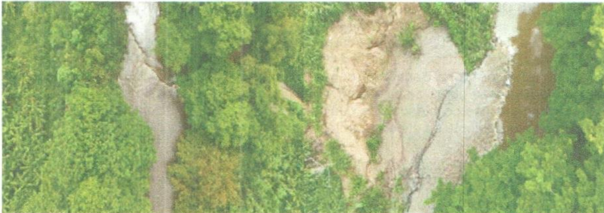
Trincho Predio Don Fuad 1
