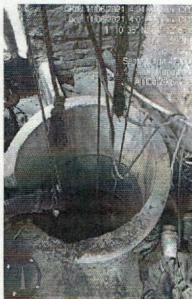
Ilustración 5. Pozo Anillado No.2
