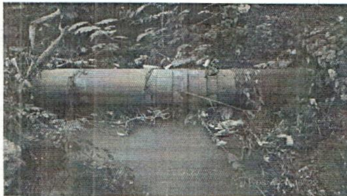
Ilustración 1. Detalle de la tubería de gasoducto existente dentro del cauce de la quebrada Palinca.
