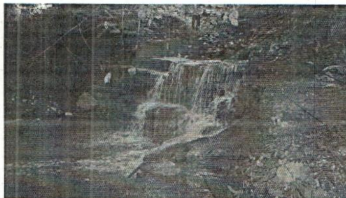
Ilustración 2. Obras para el control de erosión en el Arroyo Palinca en su estado actual, en el sector de estudio.
