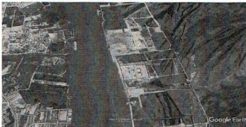
Figura No. 1. Ubicación Planta de Abastecimiento de Palermo Tanks SAS
