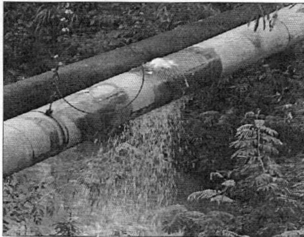
*Imagen 4. Fuga No. 3 identificada en la tubería.*
