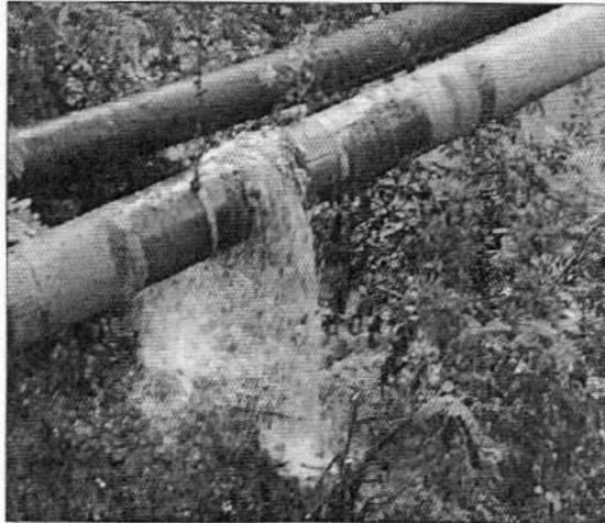
*Imagen 3. Fuga No. 2 identificada en la tubería.*
