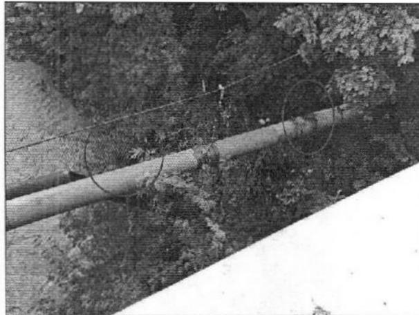
*Imagen 5. Fuga No. 4 identificada en la tubería.*
