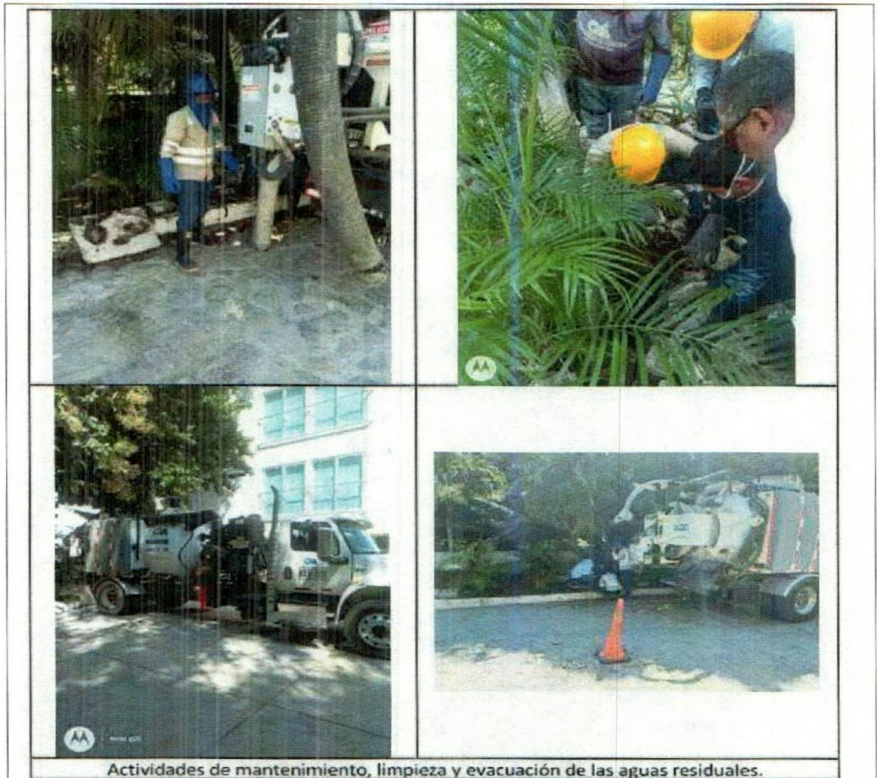
Figura 11. Imágenes de los procesos de mantenimiento y evacuación de las aguas residuales almacenadas en los tanques de almacenamiento 1 y 2 ubicados en la zona de playa concesionada
