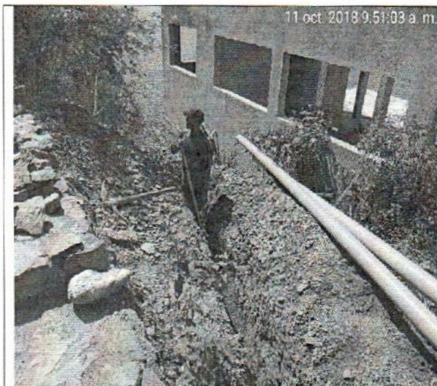
En la imagen se observa a un obrero que trabaja en la acometida de tuberías.
