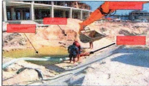
La imagen muestra una tarquina en tierra con arena depositada a su alrededor, la tubería usada para el relleno de tubos de geotextil y la bomba será colocada dentro de la tarquina
