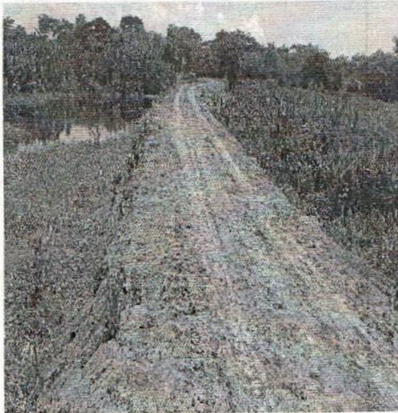
Foto1. Obstrucción del cauce del caño Ciego dentro del predio "La Legua". El carretable está conformado por un terraplén de 5 metros de corona.
