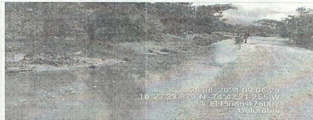
Foto3. Almacenamiento de agua de escorrentía en las cunetas de la vía. La cota del terreno de los predios adyacentes esta por encima de la cota de la rasante. La ausencia de obras de arte hace que el agua intercepte la vía y la rebase deteriorando sus condiciones
