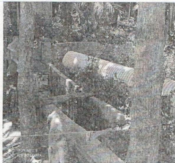
Foto6. Estructura de distribución de aguas superficiales de INVAGAMA S.A.S. La captación no se encuentra en operación por presentarse lluvias intensas en la zona que suplen el déficit hídrico del cultivo
