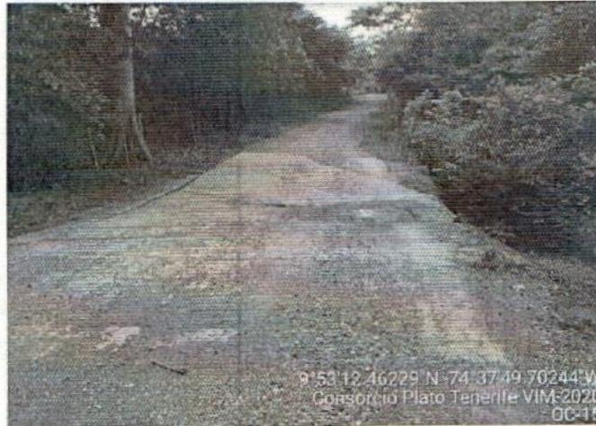
*En este punto el solicitante plantea la demolición de la estructura fracturada y la construcción de una placa en concreto reforzado, todo esto, buscando garantizar la funcionalidad de la batea.*
