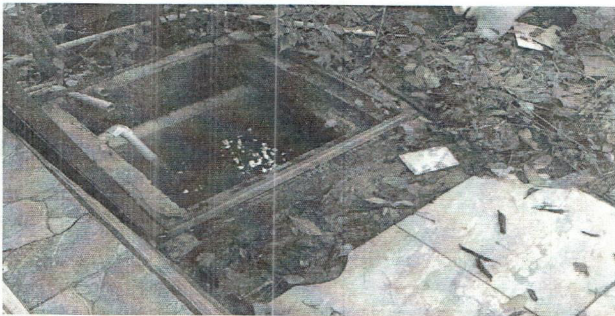
Alberca de almacenamiento.
