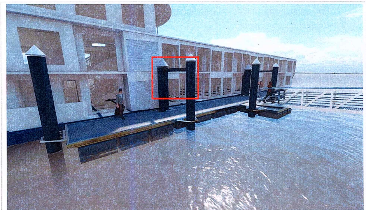
Figura 3. Pontones de atraque del muelle flotante. Fuente: Adaptado Información técnica aportado por usuario
