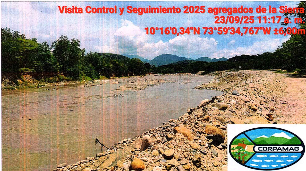
Foto 03. Vista panorámica del cauce del río Ariguani, donde se evidencia conformación de bancos de material y procesos de socavación lateral en la margen izquierda. Coordenadas: 10°16'0,34"N – 73°59'34,767"W.
