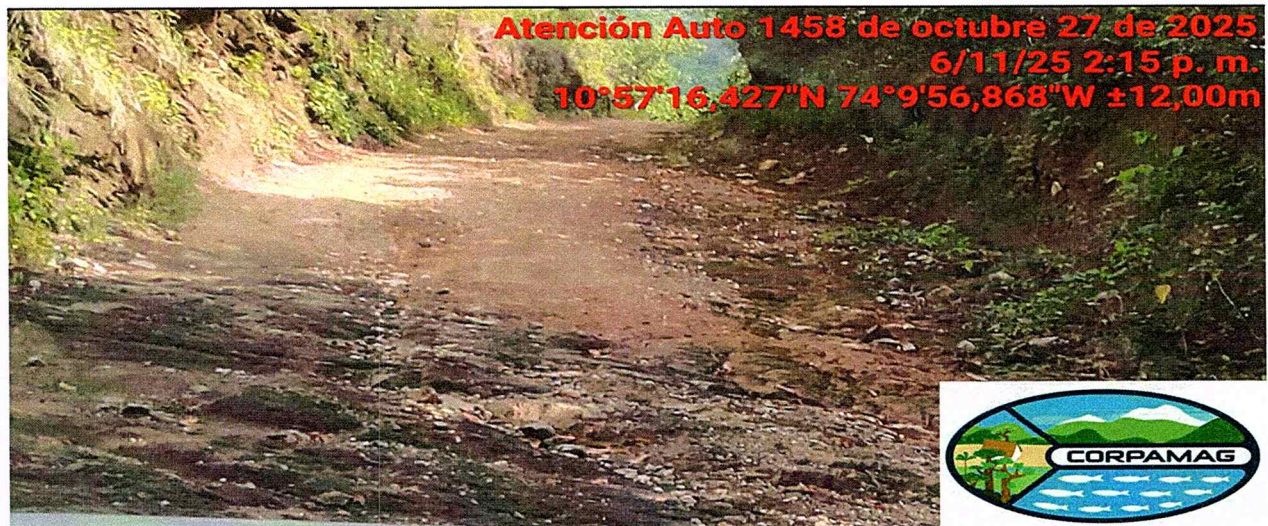
Foto 02. Detalle del camino en pendiente moderada, con exposición de suelo y pérdida parcial del afirmado.
